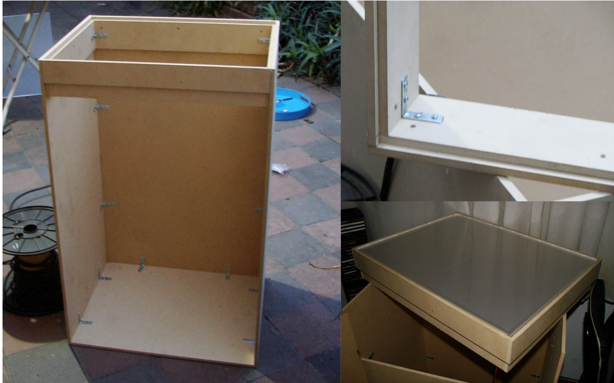
Figura 4. Construcción de la mesa. Detalle del armado.
